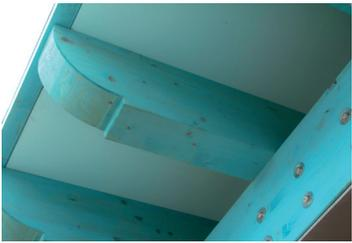
Le lavorazioni proposte oltre a migliorare l'estetica della parte terminale delle travi, consentono una protezione efficace contro il degrado dovuto alla pioggia ed ai raggi solari. Le sagome consentono di arretrare al di sotto della linea di gronda la parte più assorbente delle travi eliminando interventi manutentivi.
